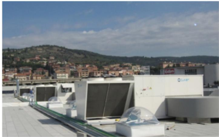
La filtración electrónica se utiliza en rooftops usados para climatizar centros comerciales o multi-cines. Este sistema es particularmente eficaz para la purificación del aire en áreas con densidad ocupacional alta.
