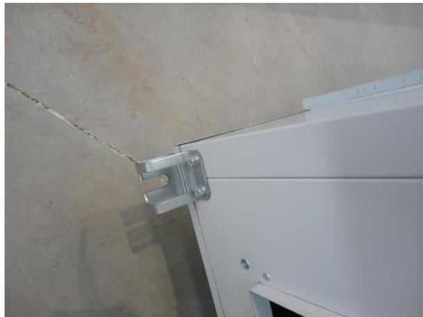
***Al instalarlo en techos, se recomienda retirar de la unidad el recuperador de calor, para reducir el peso al elevarlo para realizar la instalación.***
