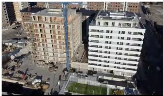
Residencial Cúbicos Viviendas
