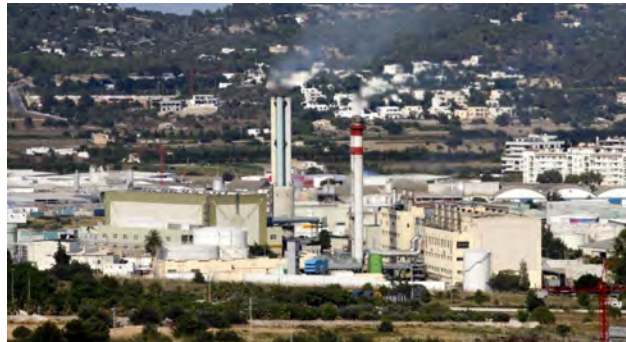
Central térmica GESA
