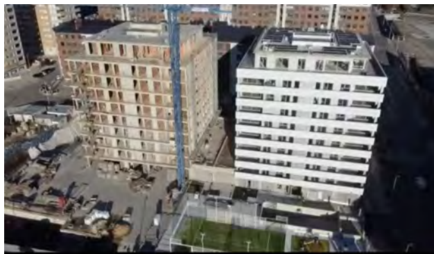
Residencial Cúbicos Viviendas
