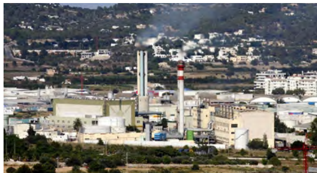
Central térmica GESA
