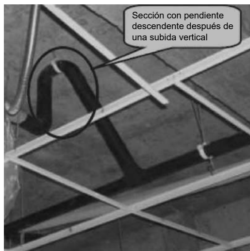
Imagen 3-6.7: Sección inclinada hacia abajo de la tubería de drenaje
