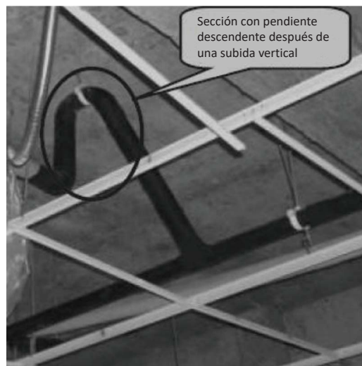
Imagen 3-5.7: Sección inclinada hacia abajo de la tubería de drenaje
